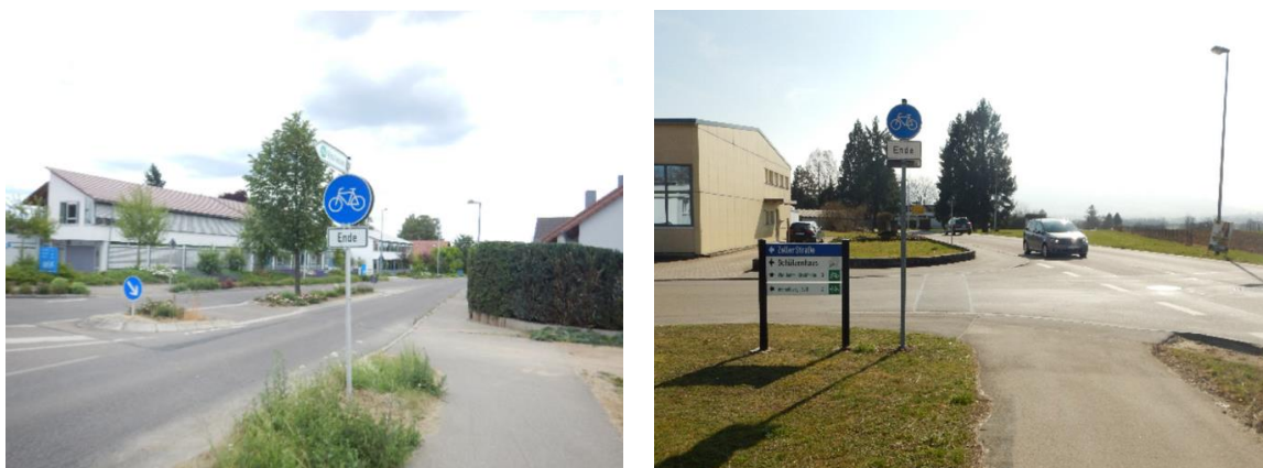
Abbildung 17: Fehlende Überführung zwischen Radweg und Fahrbahn in Wolfslungen (links) und in Holzmaden (rechts)
